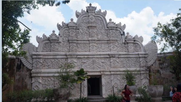
Gambar 3.16 Gapura Agung (Sumber: dokumentasi pribadi, 2017)
