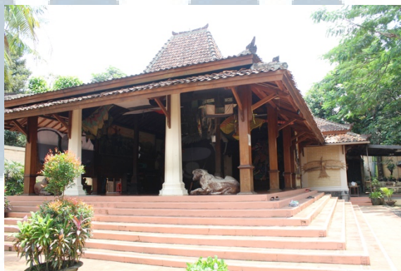
Gambar 3. 3 Bangunan utama Museum Layang-layang Indonesia
