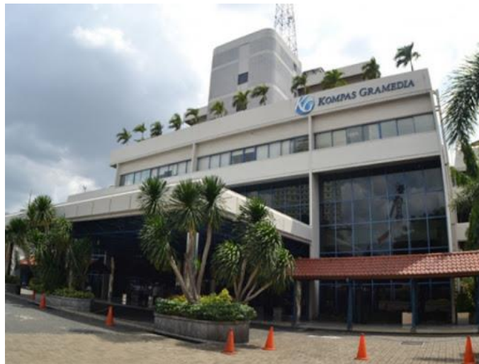
Gambar 2.1. Gedung Kompas Gramedia Palmerah Selatan (sumber: EPCON, 2012)
