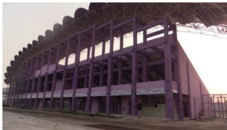
Gambar 1. 6 Stadion Benteng yang didominasi warna ungu Sumber : google image
