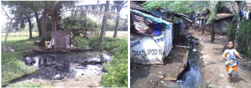
Gambar 2.34. Sanitasi yang Masih Belum Sesuai Dengan SNI di Pasir Gintung (POKJA AMPL Kabupaten Tangerang, 2012)
