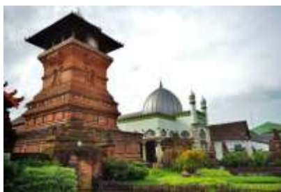
Gambar 3.18. Menara Kudus dan Masjid ( https://bobo.grid.id/read/08882128/masjid-menara-kudus-masjid-tua-dengan-menara-unik?page=all )
