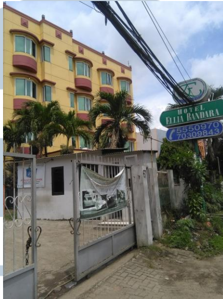
Gambar 3.13 Gedung Hotel Ellia
