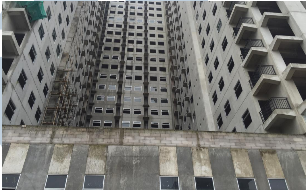
Foto Salah Satu Gedung Apartemen PT KLE
