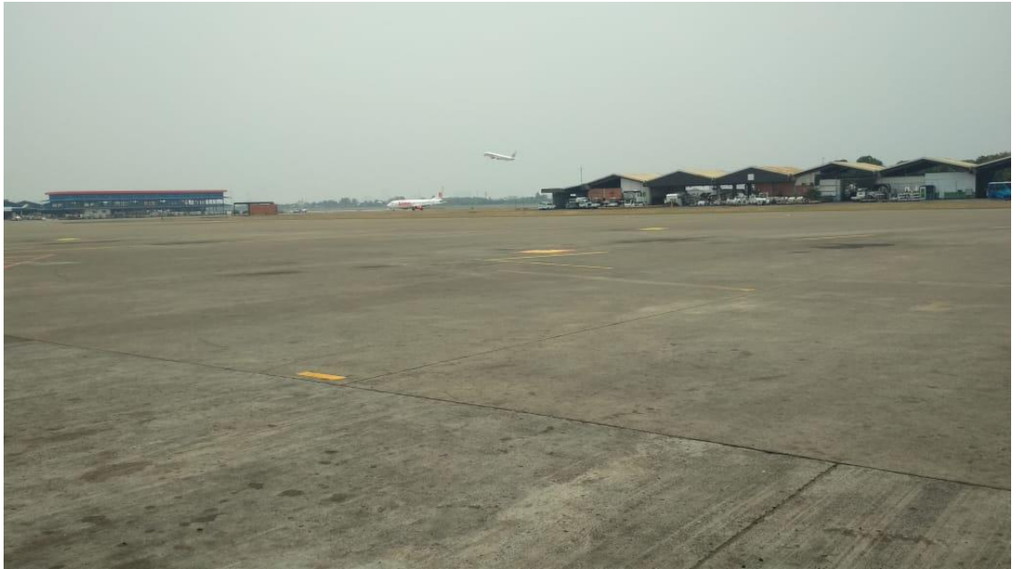
Gambar 3. 3 Apron A72 yang Akan Digunakan Untuk Parkir Pesawat Airbus 330-300CEO Batik Air
