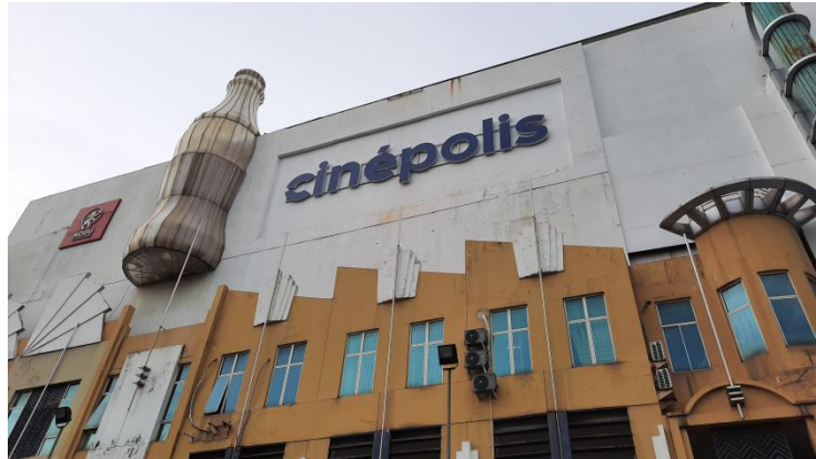
Gambar 1.5 Kondisi bangunan Metropolis Town Square
