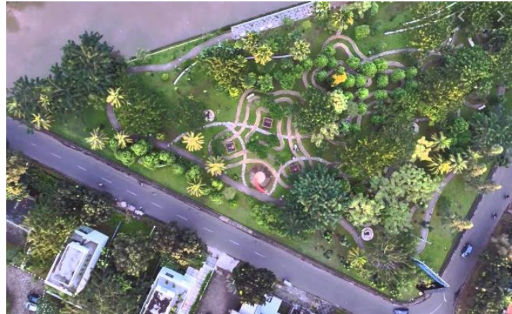
Gambar 1. 2 Menteng Park memiliki desain jogging track yang dinamis. (Sumber : Diambil dari Google Maps dan Dikembangkan Oleh Erick, 2020)
