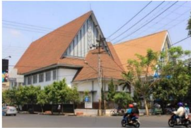
Gambar 2.29 Contoh Bangunan Indis dengan atap yang sangat miring (Model Pengelolaan Bangunan Bernilai Sejarah di Kota Malang Berbasis Konservasi Arsitektur, 2018)
