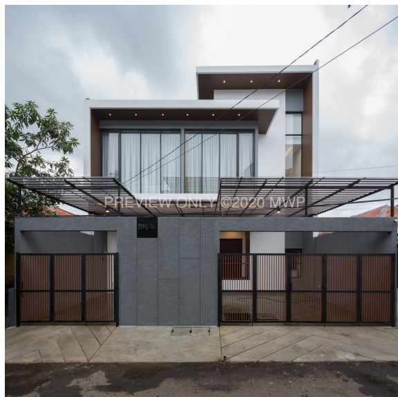
Gambar 3.2. Rumah Mr. TCL Greenville (Dokumentasi PT Aleria Pembangunan Sejahtera)
