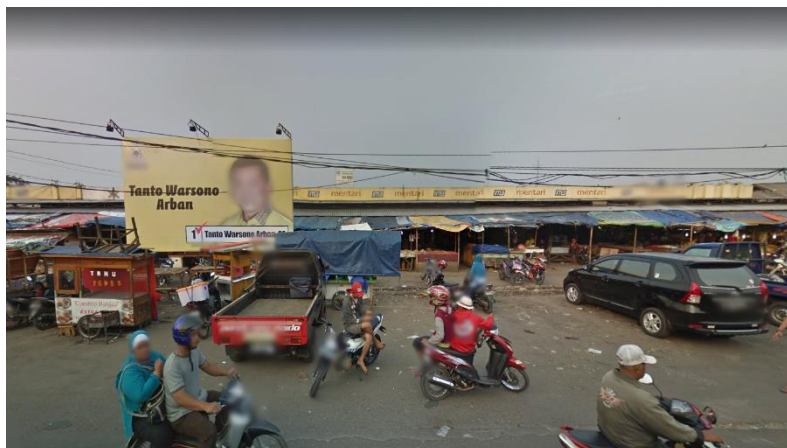
Gambar 1.7 Kondisi Sisi Depan Pasar Jombang Tahun 2019
