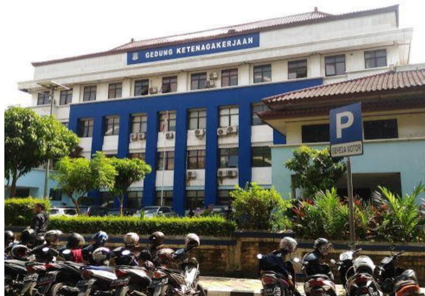
Gambar 2.1 Gedung Ketenagakerjaan (Kantor Disdukcapil lantai I dan III)
