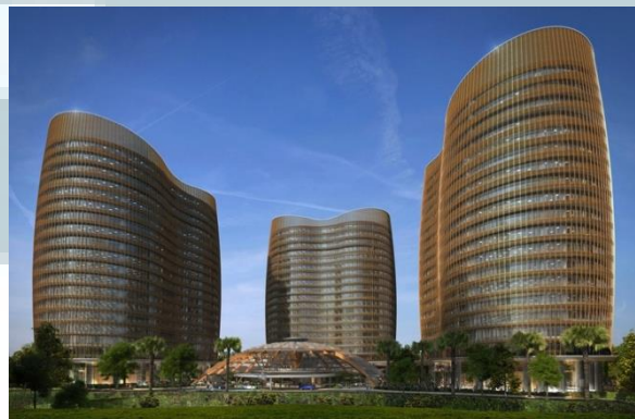
Gambar 3.12. Gedung South Quarter Jakarta
