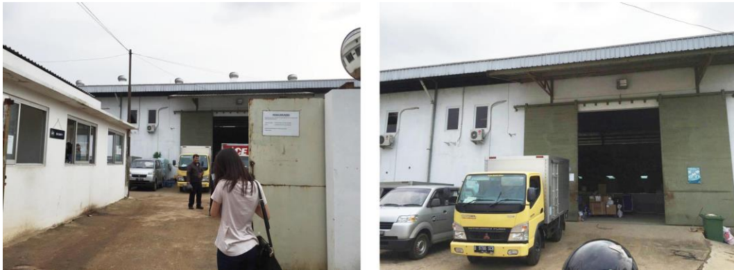
Gambar 3.5 Kondisi Gudang PT ISS Indonesia
