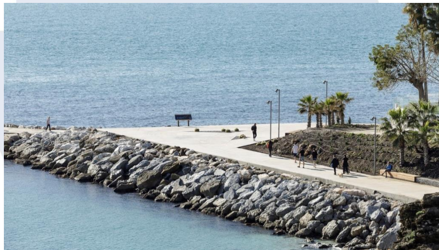
Gambar 2. 7 Sistem riprap pada Torrequebrada Promenade (Sumber: Archdaily, 2020)
