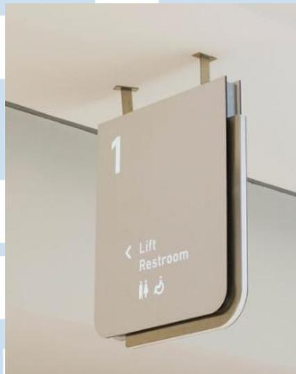
Gambar 2.11 Contoh Pemasangan *Suspended* atau *Ceiling Hung*
