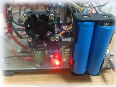
Gambar 5. 21 Tampak kondisi ATS menarik daya dari adaptor .
