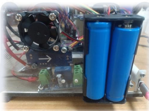
Gambar 5. 22 Tampak kondisi ATS menarik daya dari baterai.
