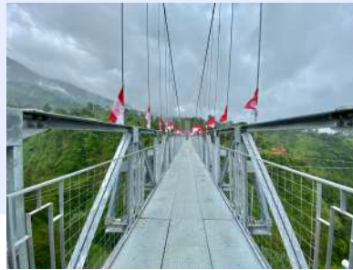
Gambar 3. 13. Suspension bridge Girpasang (Dokumentasi Pribadi, 2022)
