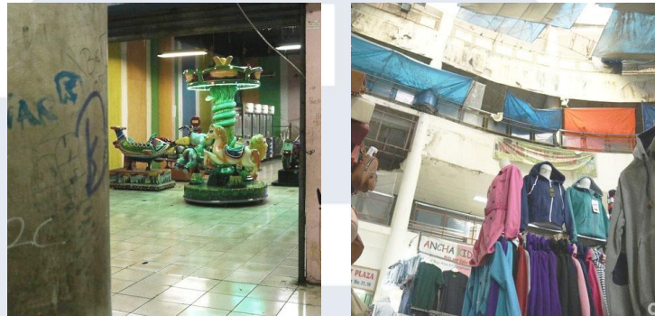
Gambar 1.8. Kondisi Fasilitas Plaza Ciputat dan Pelapukan Dinding (Sumber : detikNews, 2018)
