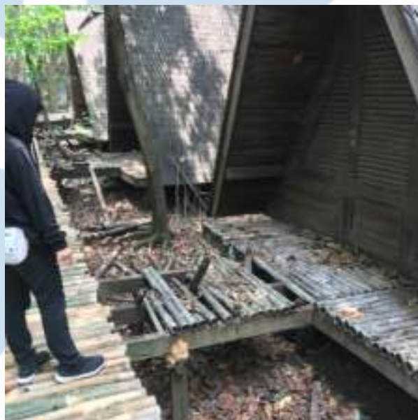
Gambar 3.12 Kondisi Perkemahan di TWA Hutan Mangrove Angke Kapuk
