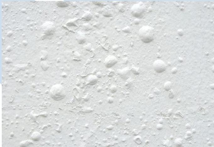
Gambar 2.15. Foto pelepuhan pada beton
