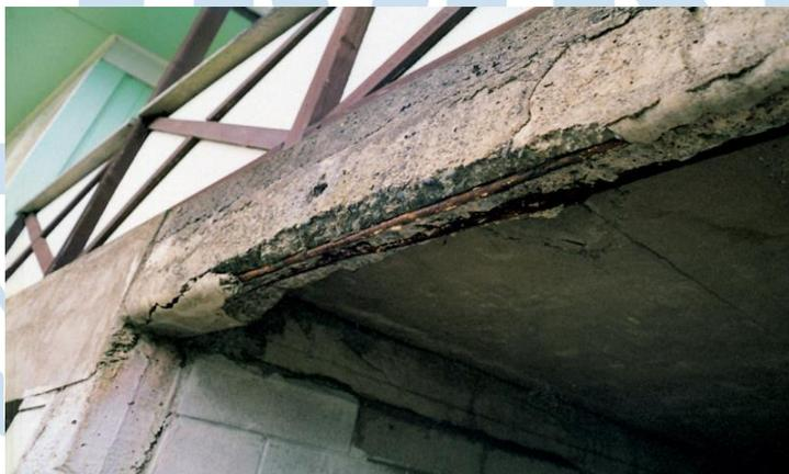
Gambar 2.18. Foto *spalling* pada beton
