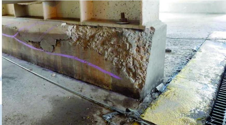
Gambar 2.16. Foto delaminasi yang terjadi pada beton
