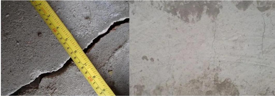
Gambar 2.14. Foto retakan dinamis (kiri) dan retakan statis (kanan)
