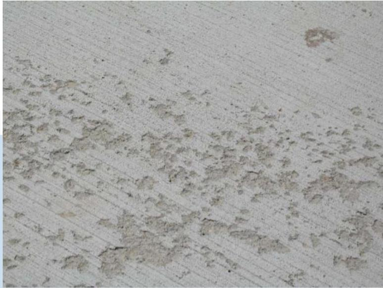
Gambar 2.17. Foto *scaling* pada beton
