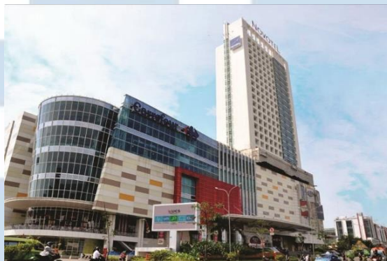
Gambar2.2 Tangerang City Mall Sumber: Website PT ITU Airconco (3 Februari 2021)
