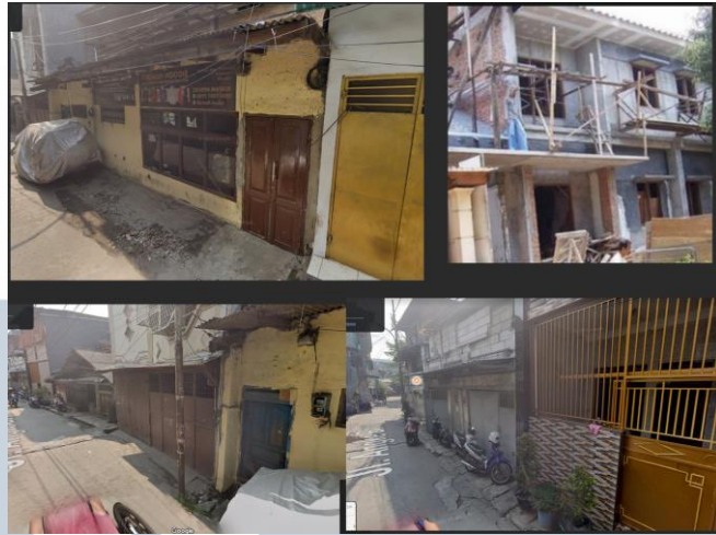
Gambar 2.1 Bentuk Bangunan (Google Street View, 2023)
