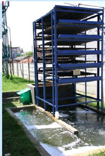
Gambar 2.6 WWTP PT. Untung Terus Sejahtera
