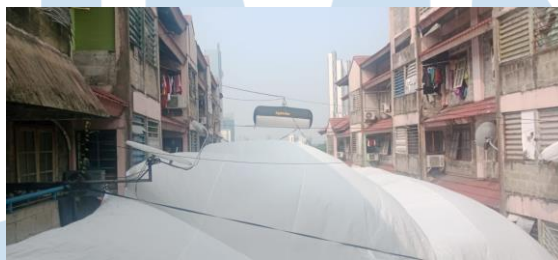
Gambar 3.4 Pemasangan Silk di Set Rusun
