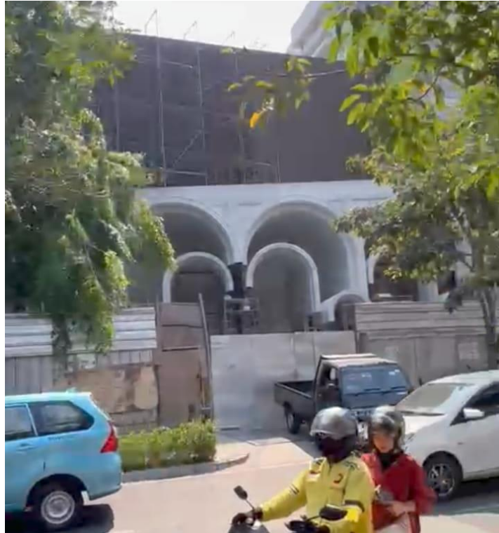
Gambar 4.9. Melihat Pembangunan yang Sedang Berjalan
