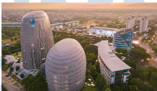
Gambar 1. 1 Gedung Universitas Multimedia Nusantara
