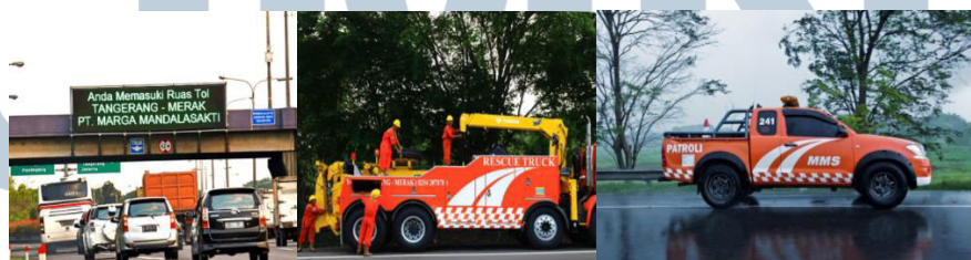
Gambar 2. 3 Fasilitas-Fasilitas Jalan Tol Tangerang - Merak
