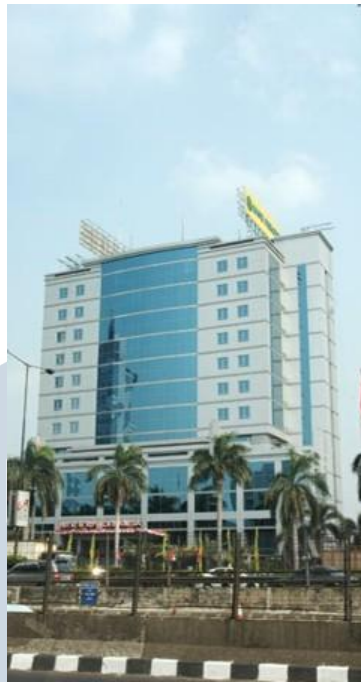
Gambar 2.1 Kantor Pusat Bukopin di Jakarta Sumber : www.bukopin.co.id
