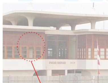
Fasad yang digunakan adalah jendela kisi sehingga dapat memanfaatkan penghawaan alami pada bangunan.
