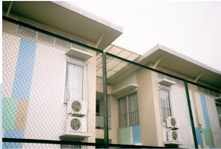
Gambar 3.3 Bangunan bagian luar Hotel D'Agape
