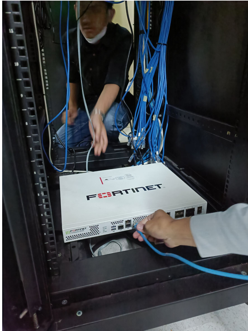
Gambar 3.13. Pemasangan Perangkat FortiGate
