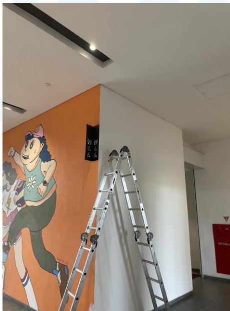
Gambar 3.19 Pemasangan Mockup Signage
