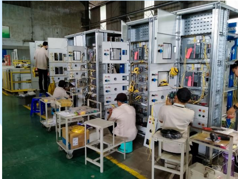
Gambar 2. 3 Perakitan Panel Listrik (Dokumentasi Pribadi)
