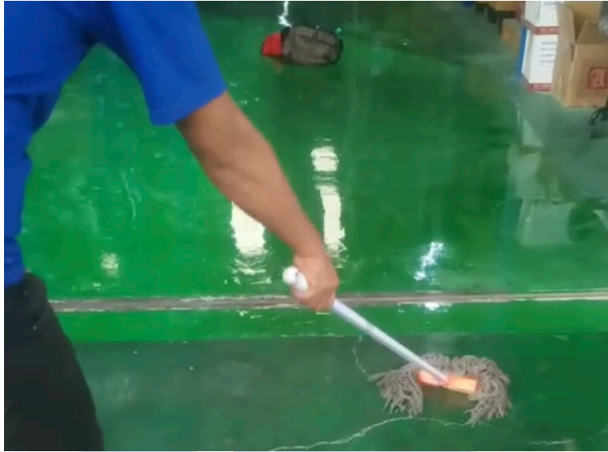
Gambar 3. 28 Proses Perbaikan Lantai Epoxy di Gudang Rawagelam
