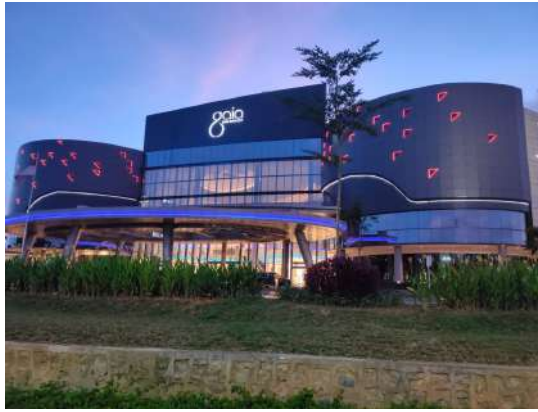
Gambar 1.2 Bangunan Gaia Bumi Raya City Mall
