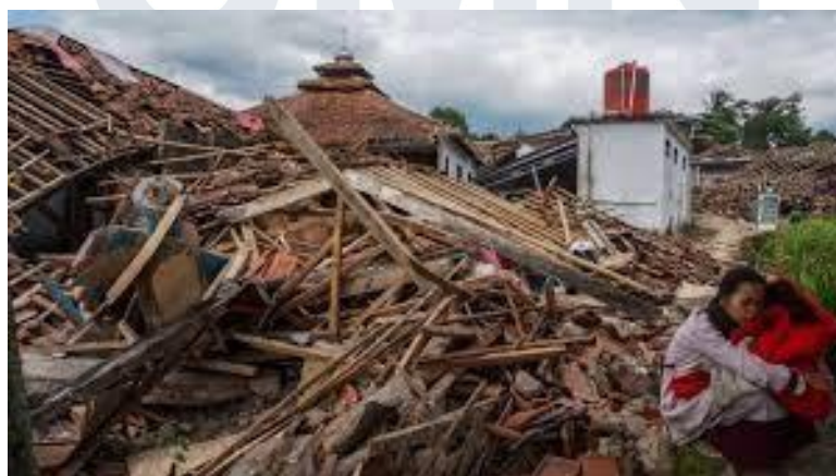
Gambar 1.3 Kerusakan akibat bencana alam
