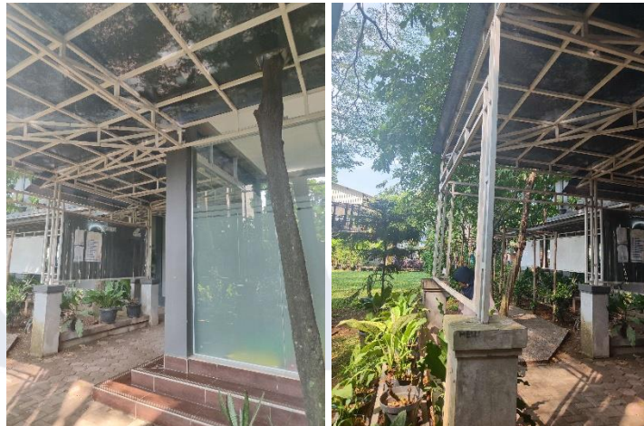
Gambar 2.44 Gedung Fasilitas Pendukung Sekolah
