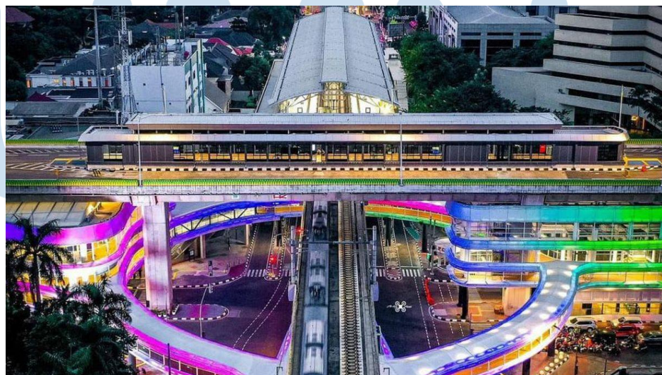
Gambar 3.10 Kondisi Stasiun MRT Pemberhatian ASEAN
