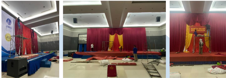
Gambar 3. 8 Proses pemasangan tirai (Sumber: Dokumentasi pribadi)
