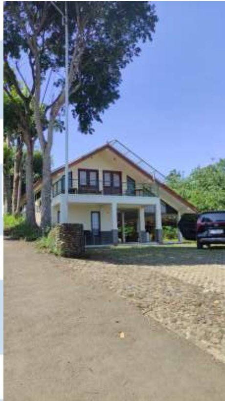
Gambar 3.25 Foto Cabin Jati yang belum dilengkapi identification signs tempat
