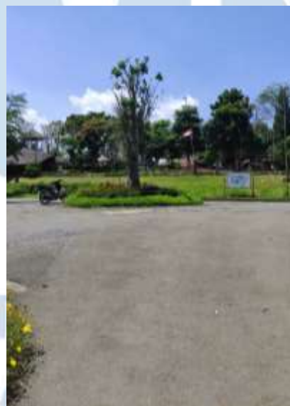
Gambar 3.17 Tidak ada signage dibundaran pertigaan
