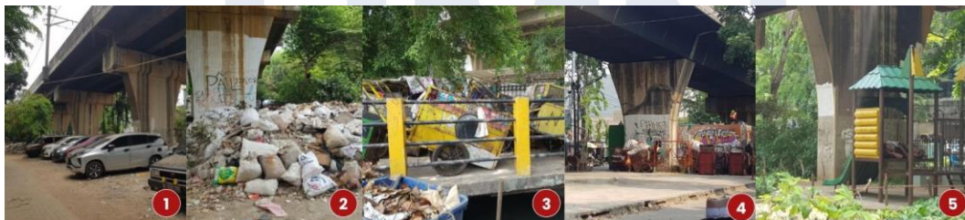
Gambar 1.3 Kolase Foto Negative Space Ruang Bawah Kereta Layang (1) Parkiran liar; (2) Penumpukan sampah; (3) Jembatan kali beralih fungsi menjadi tempat penyimpanan gerobak sampah; (4) Fasilitas ruang publik bersebelahan dengan TPS; (5) Beberapa orang tidur di sembarang tempat
