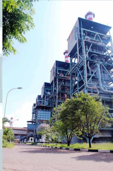
Gambar 2.7 Pembangkit Listrik Tenaga Uap (PLTU) PT KDL
