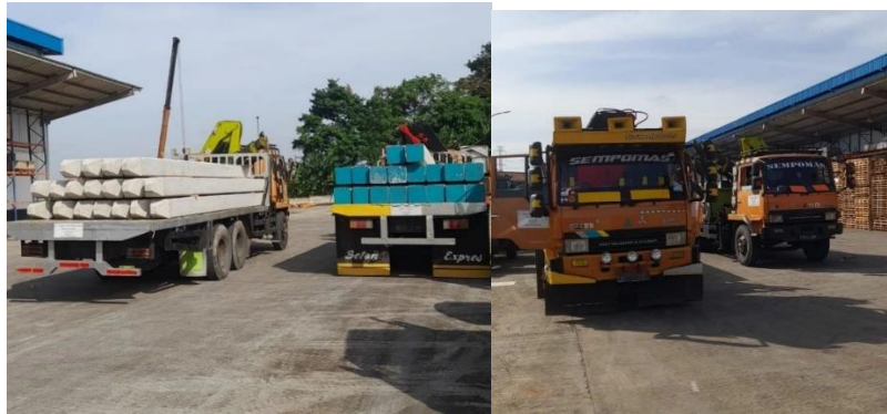
Gambar 3.9 Pengiriman tiang pancang menggunakan truk tronton
