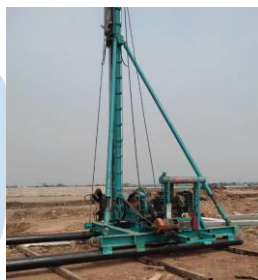
Gambar 3.10 Alat berat yang digunakan untuk pemancangan
