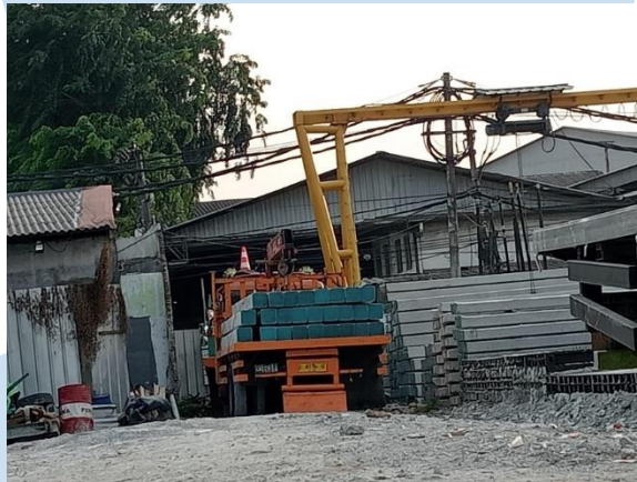
Gambar 3.8 Gambaran proses pemancangan
