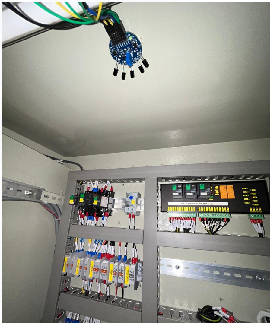
Gambar 3.14 Penempatan flame sensor
