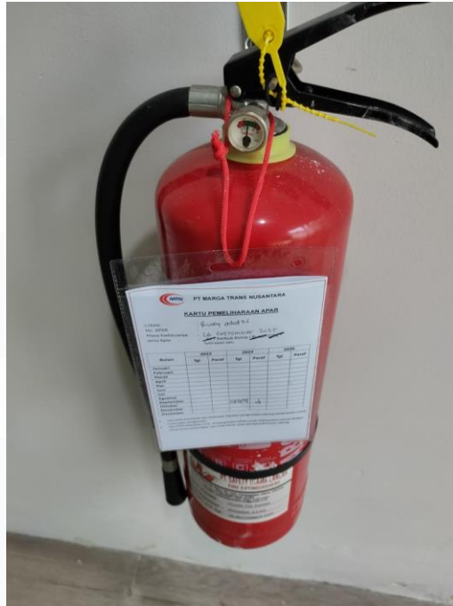
Gambar 3.1.9 Melakukan pengecekan APAR & membuat kartu APAR
