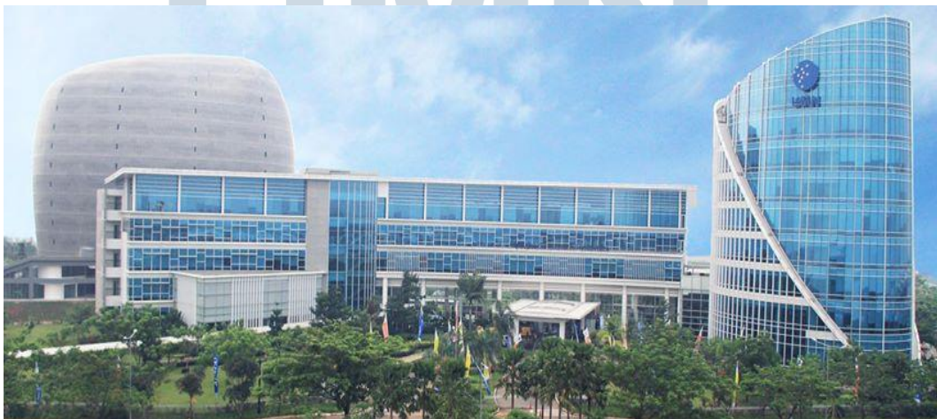
Gambar 2.1 Gedung Universitas Multimedia Nusantara
